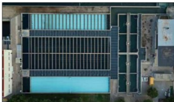
FIGURA 6. Decantadores D y A con lamelas WssDynamics.
