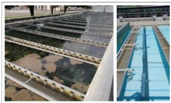
FIGURA 3. Decantador con lamelas antiguas y decantador D con lamelas WssDynamics y equipo de limpieza.
