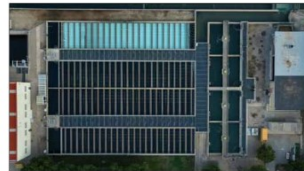
FIGURA 4. Vista aérea de los cuatro decantadores de la ETAP de Majadahonda. El decantador D es el modelo de lamelas WssDynamics instalado.
