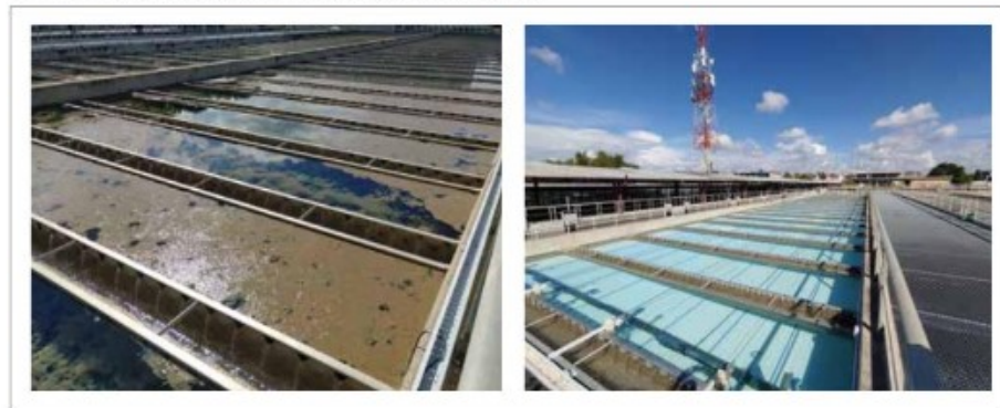
FIGURA 9. Estado decantadores C y D a fecha 21 de octubre de 2022.
