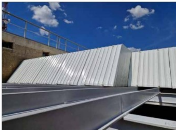
FIGURA 2. Vista inferior de nuevos módulos lamelares y soportes.
